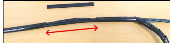
Abb. 15 – Kabelummantelung mit Lücke.
